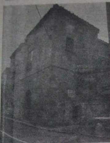
Casa del Hidalgo. En ella están instalados los fondos del Museo Provincial.
